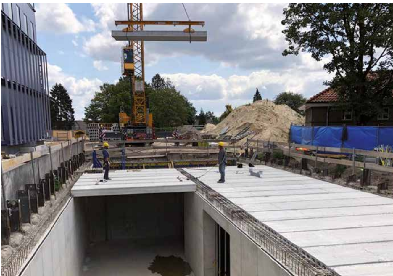
De betonwanden zijn geplaatst
