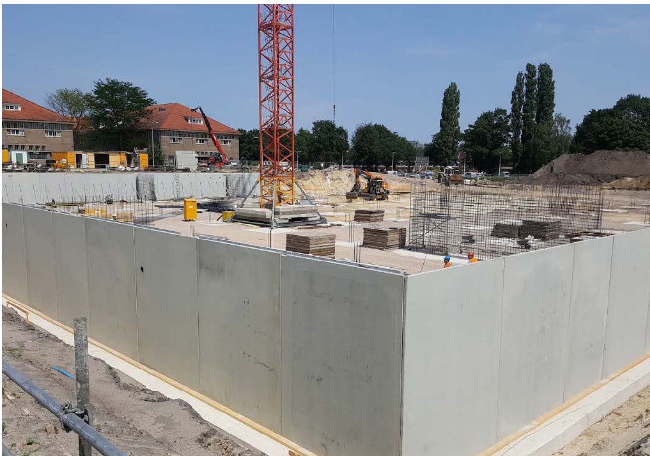
Het plaatsen van de holle wanden is voor 50 % gereed
