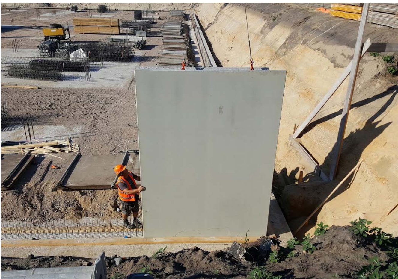
Op de foto wordt de 1e holle wand geplaatst ten behoeve van de kelderwand
