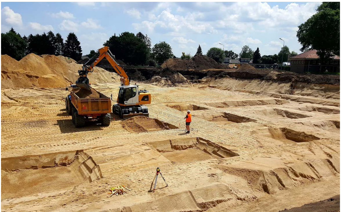
Nadat de gehele bouwput is uitgevlakt, kan men beginnen met het ontgraven van de poeren
