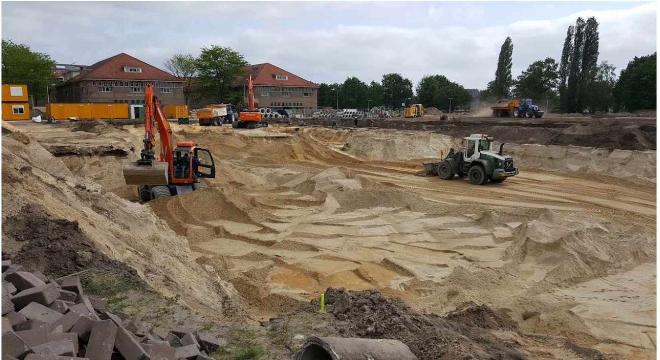
Aannemer Wijnen Bouw BV uit Schijndel is gestart met ontgraven van de enorme zandvlakte
