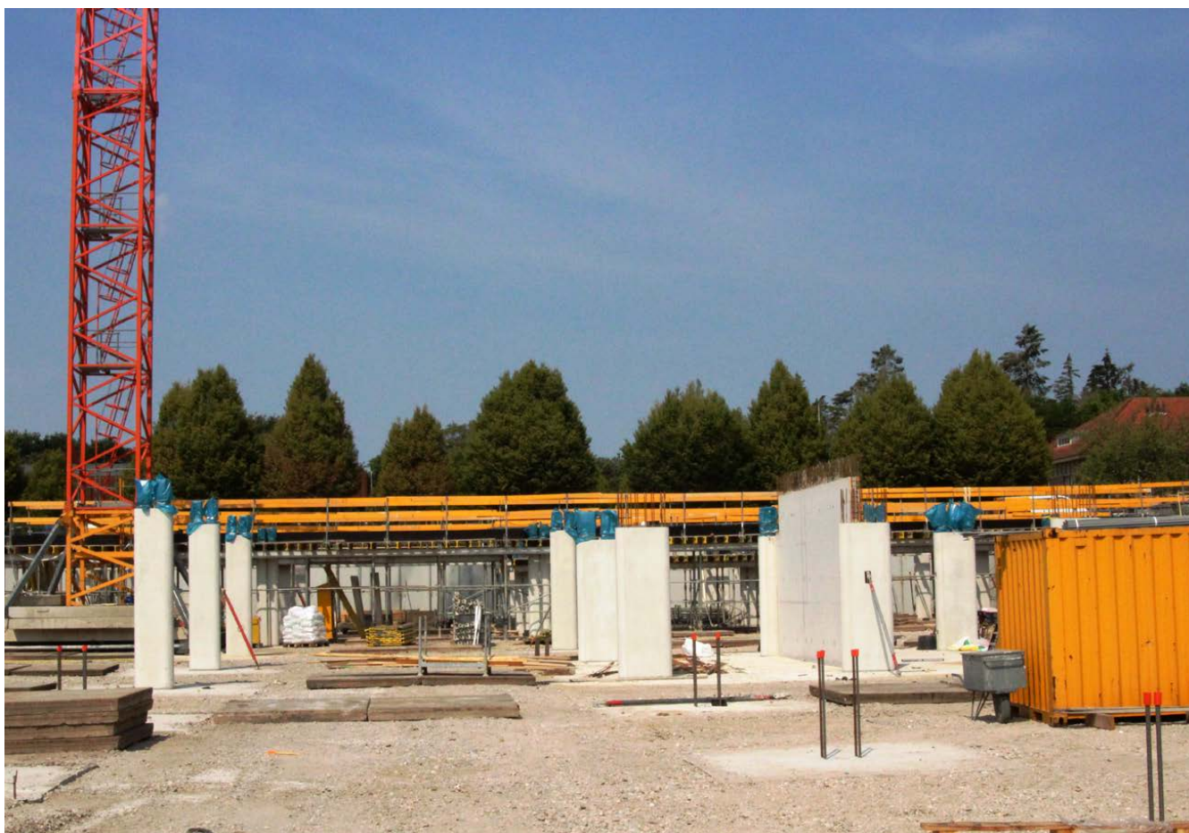
Nadat alle holle wanden zijn geplaatst en gestort zijn met beton is men begonnen met de voorbereiding voor de vloer van de begane grond
