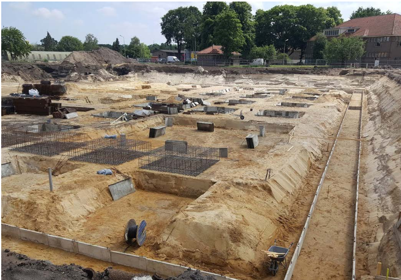
Nadat alles is ontgraven kan men de bekisting aanbrengen voor deze poeren. Een poer is een ondersteuning voor de fundering van het gebouw. Deze is 12 x 12 meter en bestaat uit 120 m 3 beton
